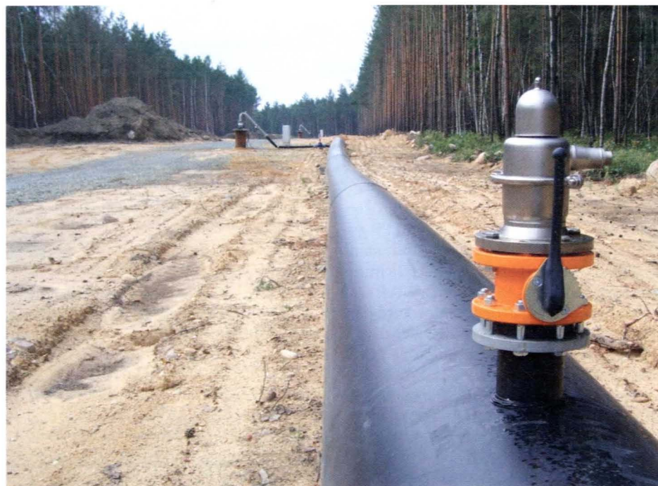
Bei großen Kunststoffrohrleitungen sorgen Be- und Entlüftungssysteme für eine ausreichende Betriebsentlüftung mit großem Lufteintrag
